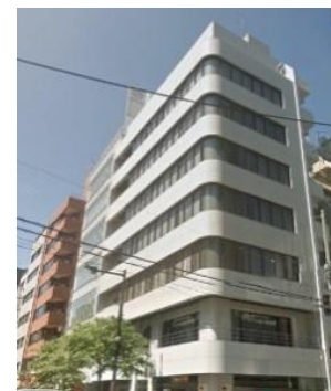
福岡：博多1091ビル
